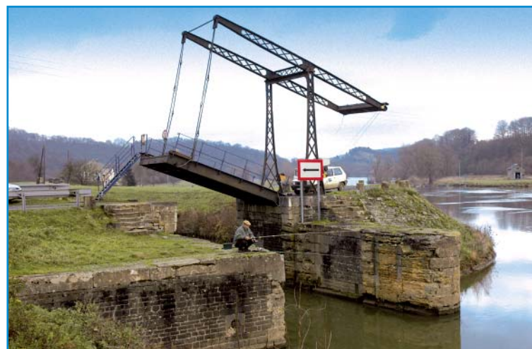
Aubrives: eine halb geöffnete Hebebrücke mit verbotenem Übergang . . .
