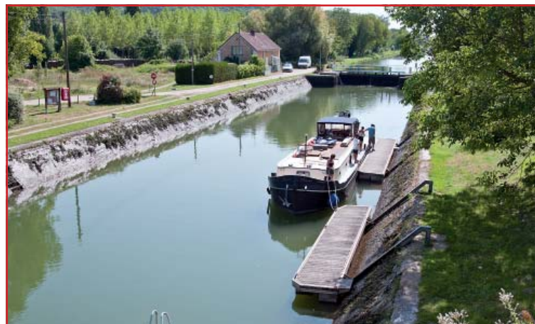
Schleuse 3 bei St-Aubin-sur-Yonne mit schrägen Wänden und Schwimmponton.
