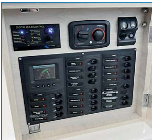
Der Motor unter der Außen-Sitzbank, Sicherungen und Heizungs-/Lüftungs-Steuerung und der Grundriss der Horizon
